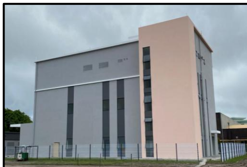
Projek Kesihatan Seperti National TB Reference Laboratory (NTRL) & Virology Services; dan Pembinaan Blok Baru Pusat Kesihatan Jubli Perak Sengkurong
